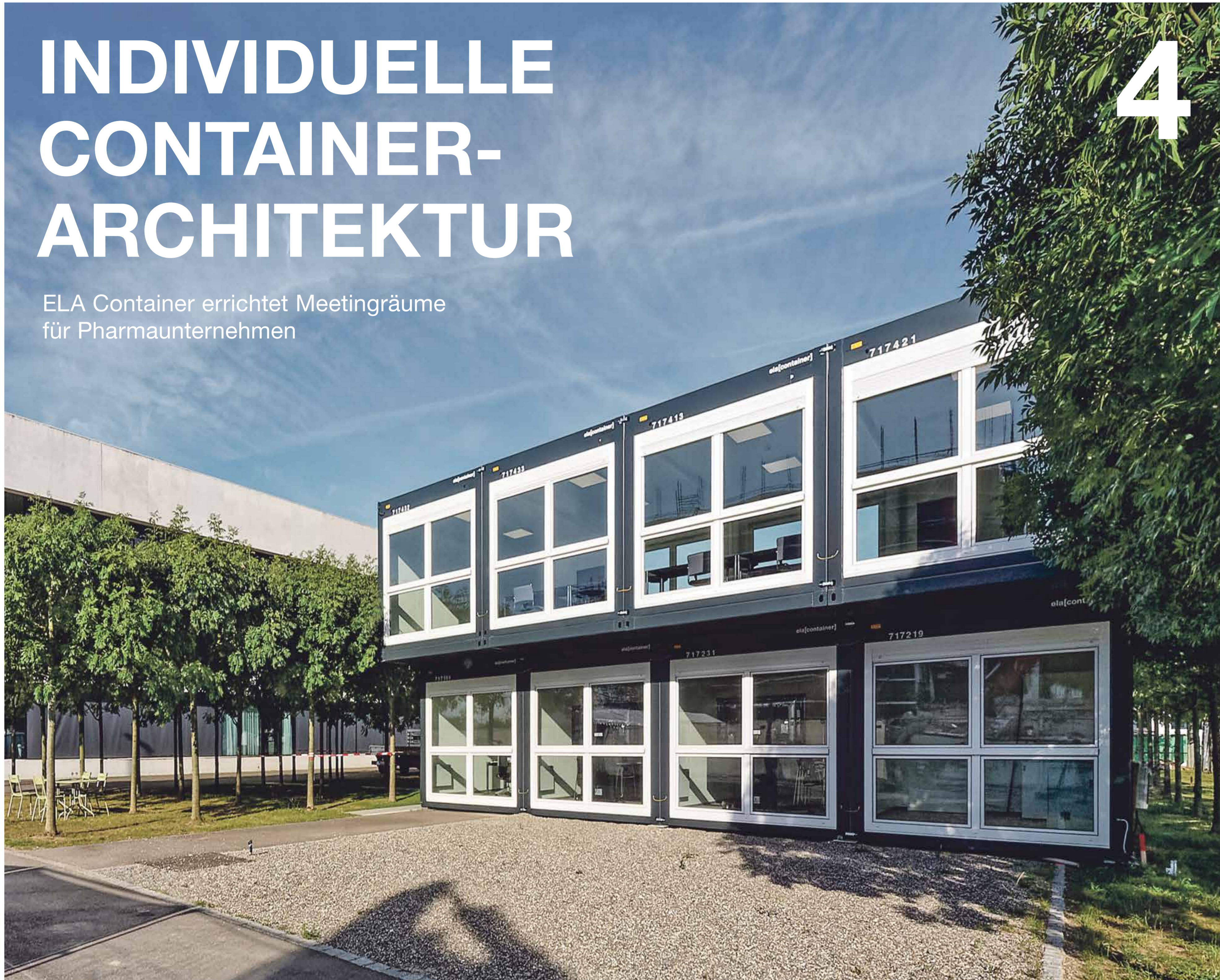
Statisch anspruchsvoll: Auf Wunsch des Kunden montierte ELA die einzelnen Containermodule versetzt übereinander.
