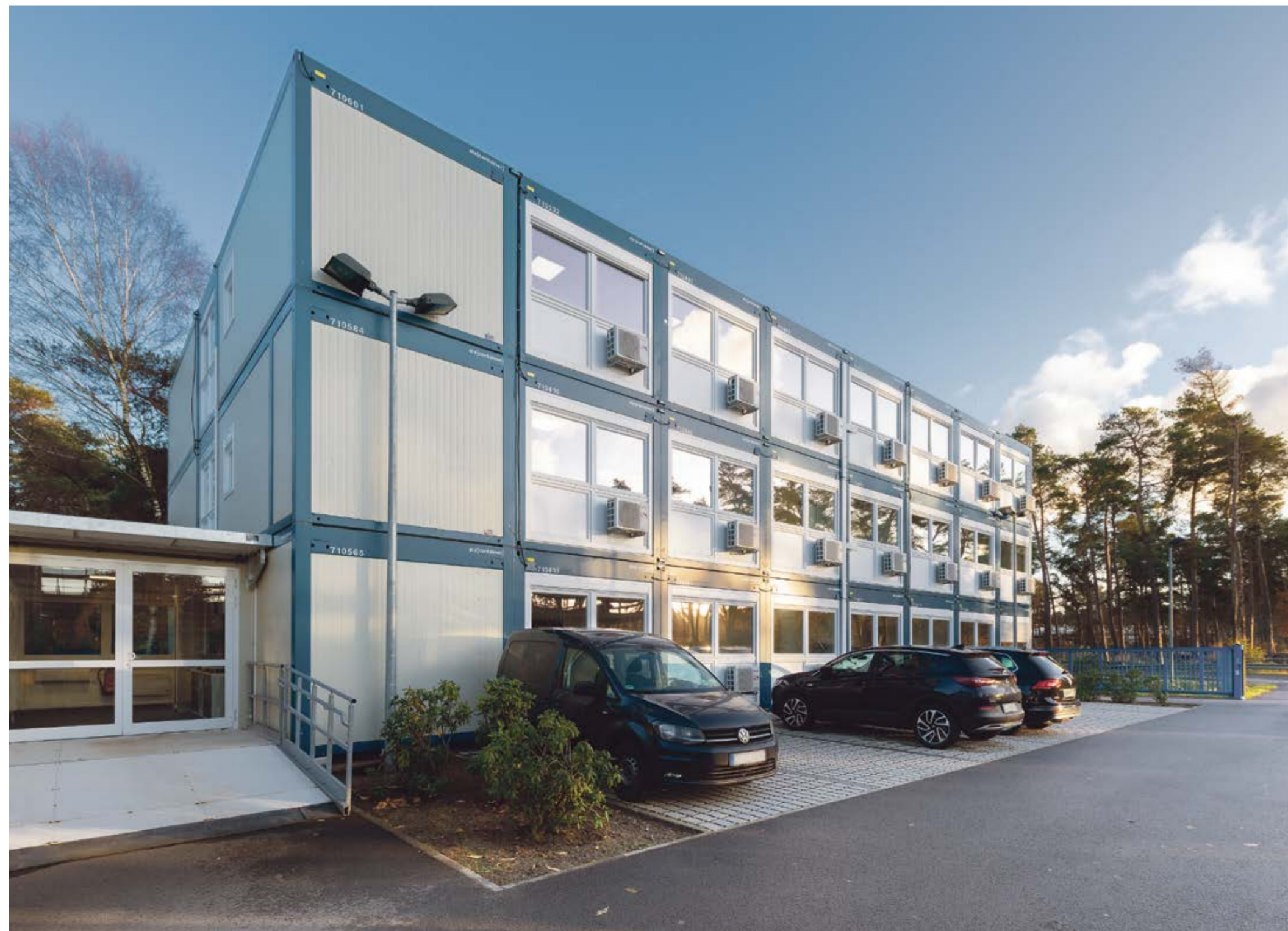
Mit etwa 1.250 Quadratmetern bietet das Gebäude viel Platz für die Verwaltungsmitarbeiter.
