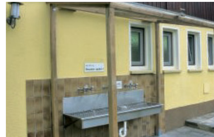
Pfiffig: Die selbst gezimmerte Überdachung über den Geschirrspülbecken sorgt für trockene Füße.
