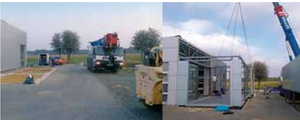
▲ Nachdem die Fundamentarbeiten abgeschlossen waren, benötigte der Aufbau der beiden neuen Werkstattmodule lediglich zwei Tage.
